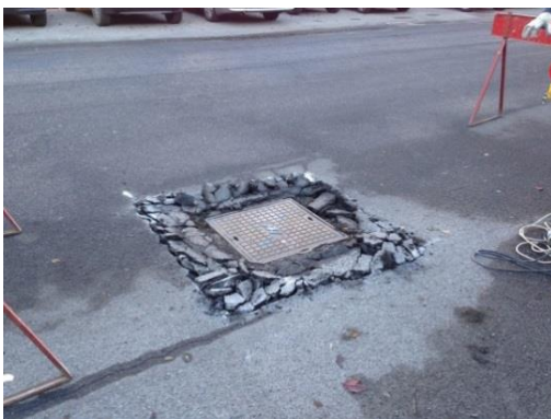
Taglio della pavimentazione
