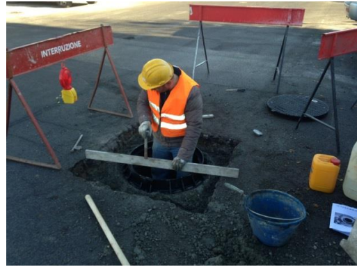
Livellamento del telaio in quota
