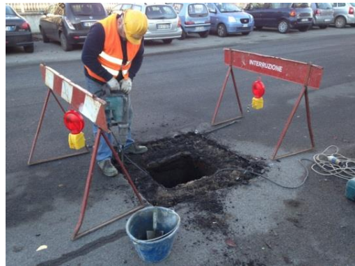
Rimozione del materiale attorno al telaio
