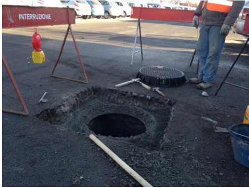
Pulizia dell'area interessata
